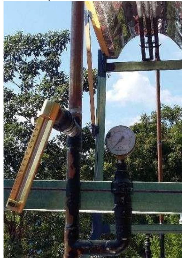
Figura 8.- Instalación de la tubería con sus instrumentos de medición de temperatura y presión.
