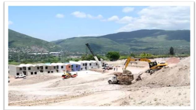
Figura 3. Construcción del Nuevo Mirador 2014 Figure 3. Construction of the Nuevo Mirador 2014
