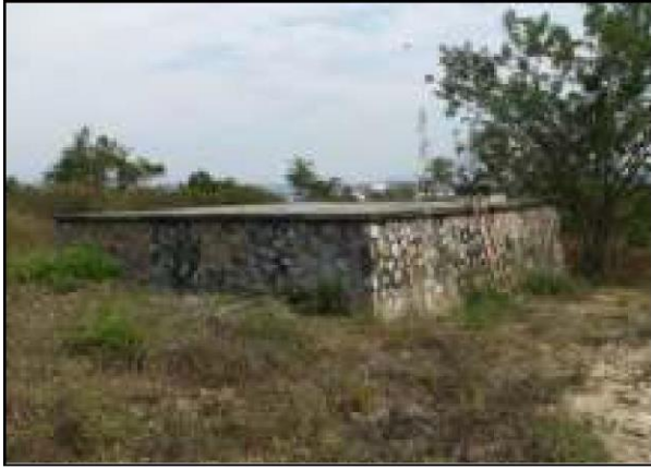
Figura 3. Abastecimiento de agua potable en el ITA. Tanque de mampostería
