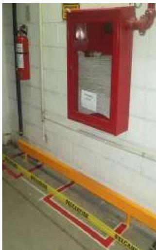
Fig. 11 Delimitación de hidrante y extinguidor.
